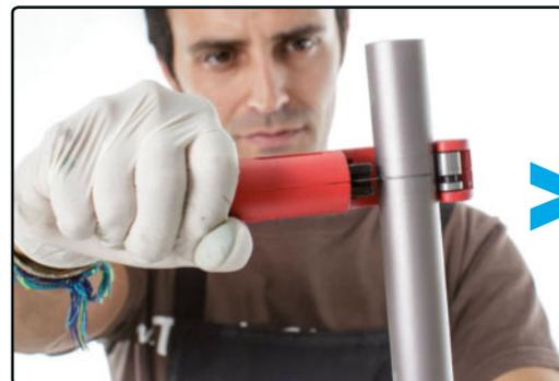
**PASO 6>** Tras realizar el corte, repasa con una lima para metal los bordes externo e interno.
